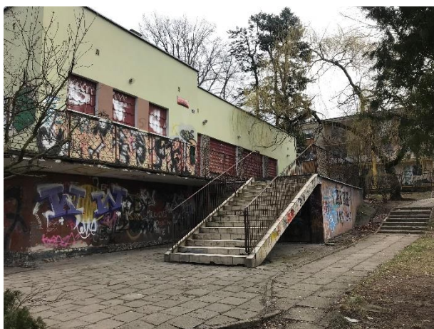
Zd. 5 Spacer badawczy (5 kwietnia 2022) Widok na budynek Domu Weterana (źródło: A2P2)
